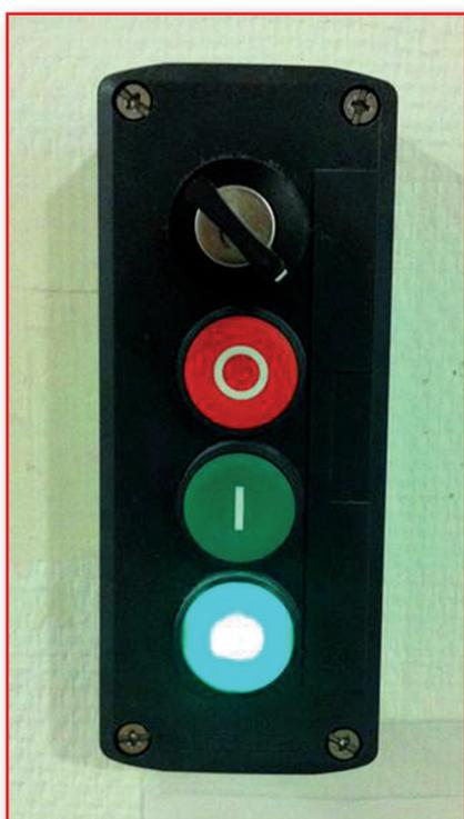
**Figura 2.** Botones de encendido/apagado de TC.
