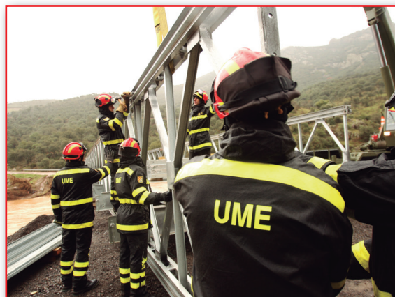
Figura 11. UME; instalación de un puente en Mestanza (Ciudad Real).
