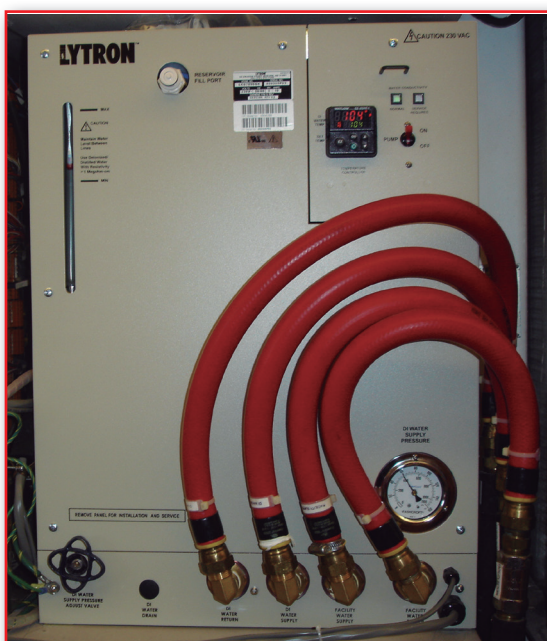
Figura 29. Bomba de agua para la refrigeración (imagen cortesía del Parc de Salut Mar).
