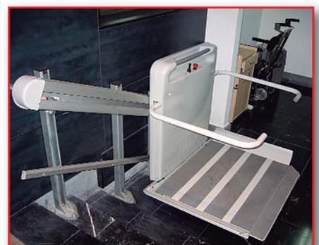
**Figura 15.** Plataforma de elevación inclinada.
